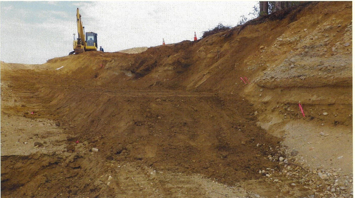
作業用足場（南から）
