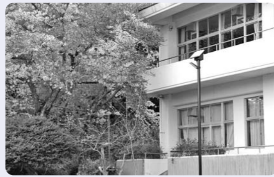
幾世橋小に設置されたソーラー街灯
