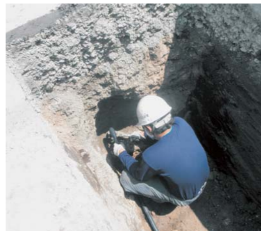
上水道の漏水修繕工事の様子
