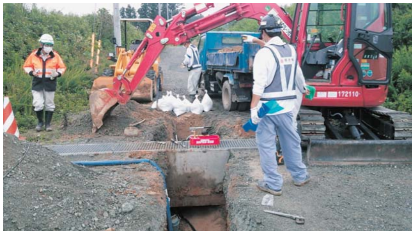
常磐自動車道の浪江IC開通に伴い行われた、浪江IC事務所への給水管接続工事
