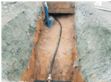
常磐自動車道の浪江IC開通に伴い行われた、浪江IC事務所への給水管接続工事
