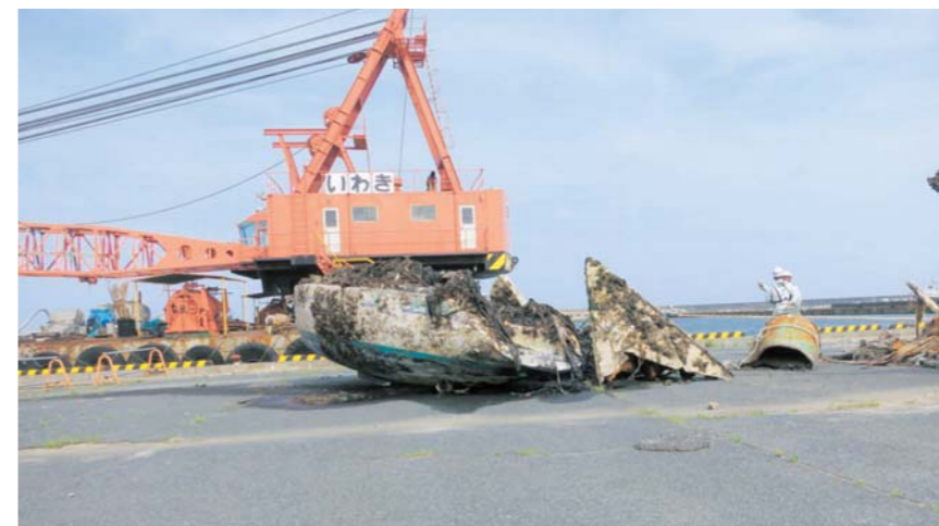
請戸漁港の復旧作業においても、港内に沈んだ災害廃棄物の撤去、および浚渫(海底の土砂を取り除く作業)が始まりました。(福島県の事業)
