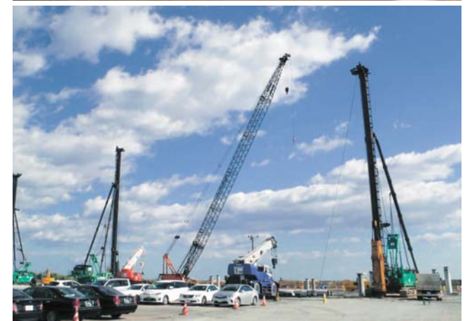
杭打ち作業の現場
