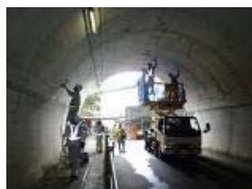
(トンネル点検)
