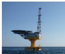
洋上変電所 「ふくしま絆」
