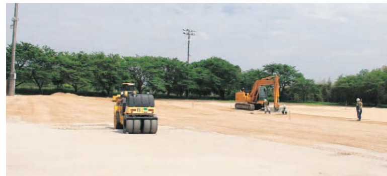
除染作業中の幾世橋小のグラウンド
