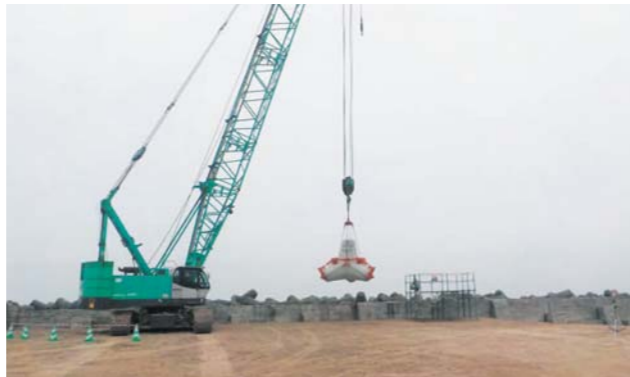
消波ブロックの据付を開始
