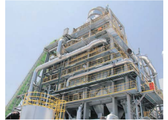
1日300トンの処理能力を持つ焼却炉
