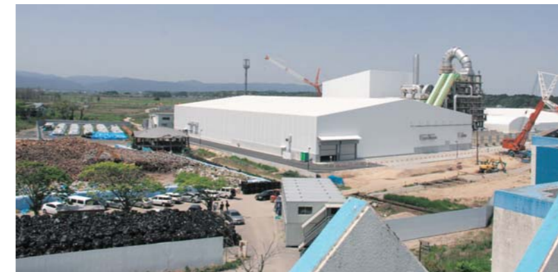
マリパークから見た仮設焼却施設。7月から本格稼働します。
