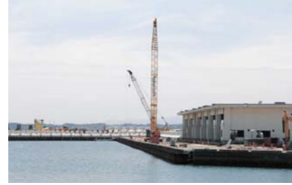
復旧が進む請戸漁港
