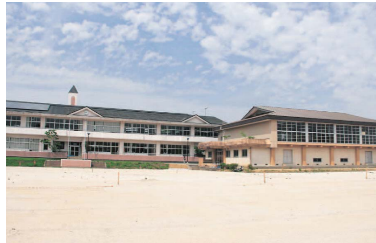
除染が終わってきれいになった幾世橋小の校庭
