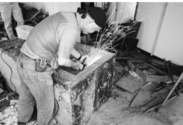
金庫の解体の様子
