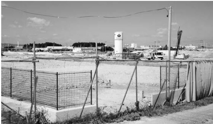
復興公営住宅造成工事（南相馬市北原）
