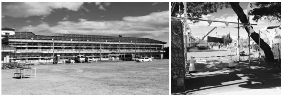
除染をして戻れるか、検証が待たれる除染現場（左：浪江中、右：浪江小）
