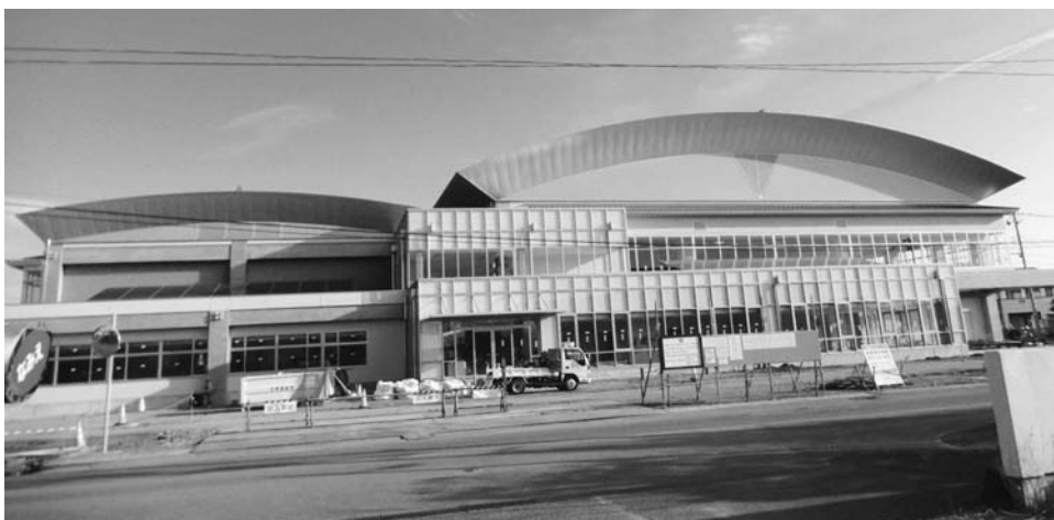
完成間近の地域スポーツセンター
