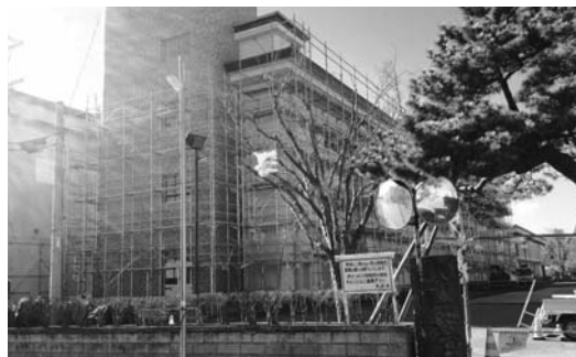
権現堂地区の除染作業
