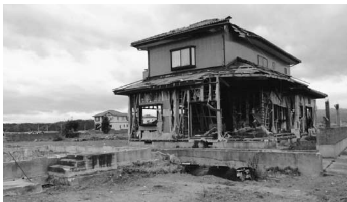
津波被災住宅
