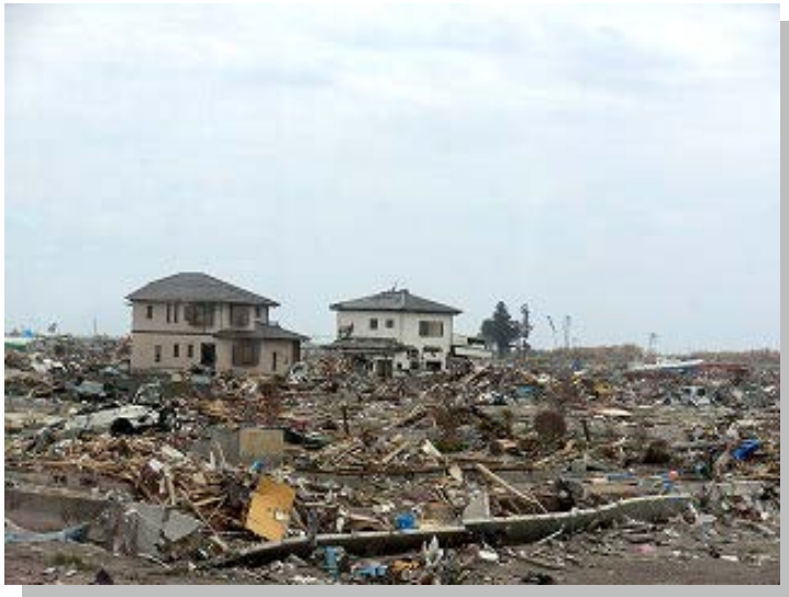
【請戸地区】（平成 24 年 5 月 27 日撮影） 津波によって多くの家屋が流出している。
