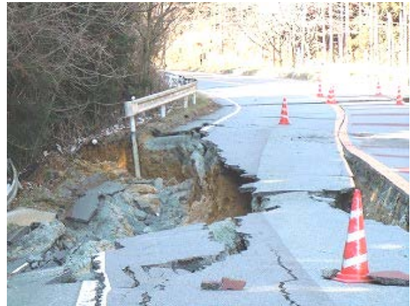
地震の影響で崩れた道路 (平成 23 年 3 月 28 日撮影)
