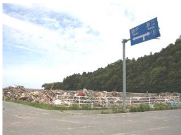
請戸を示す案内板と瓦礫 (平成 23 年 5 月 27 日撮影)
