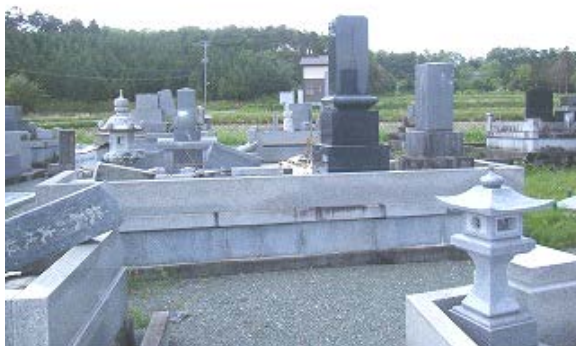
地震で被害を受けた墓地 (平成 23 年 5 月 13 日撮影)
