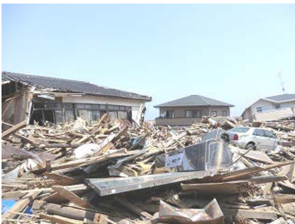
【両竹地区】（平成 23 年 4 月 16 日撮影） 津波によって家屋や車等が流され瓦礫となって山積みしている。
