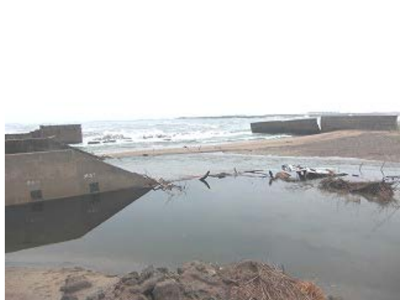
津波により破壊された防波堤 (平成 24 年 2 月 7 日撮影)
