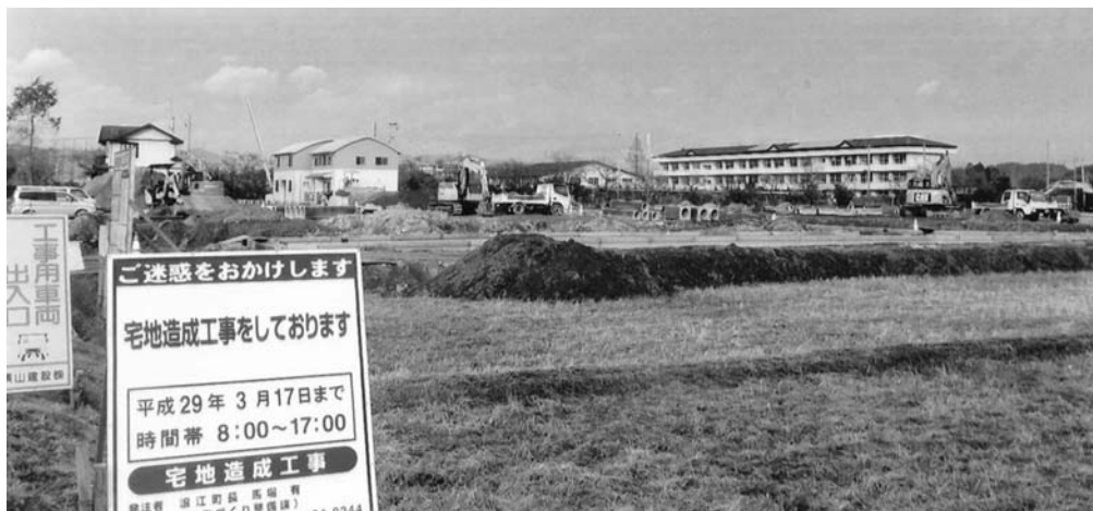
災害公営住宅の敷地造成 (幾世橋地区)
