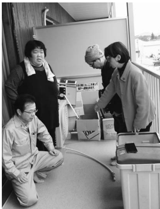
エアコン排水施工欠陥の改善を求めた現地調査 (二本松・石倉団地4号棟)
