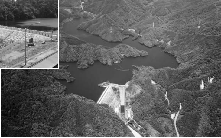
堤体の復旧が完了し、水位上昇試験中の大柿ダム (H28.5)
