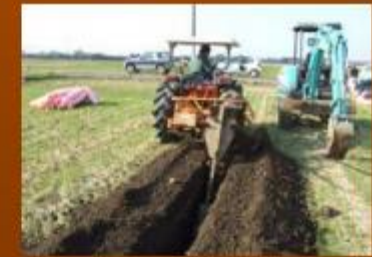
暗渠排水の設置
