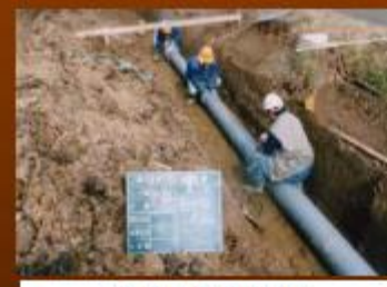
農業用水路の設置
