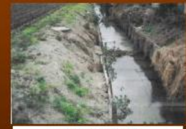
老朽水路の改修
