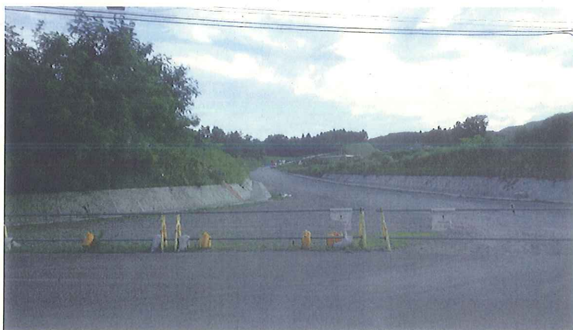
(国道114号線から見た工事中の浪江IC)
