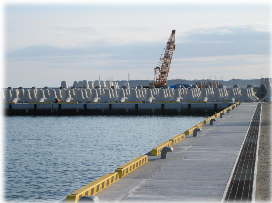
整備中の請戸漁港
