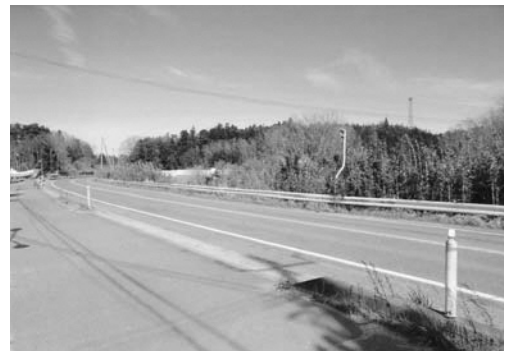
見通しの悪い接続箇所
