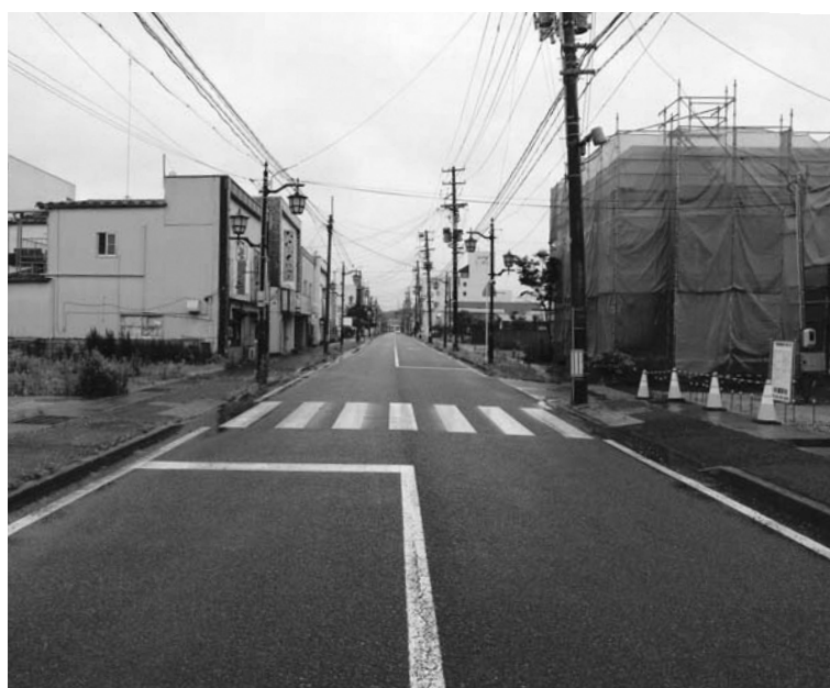
解体が進む新町通り
