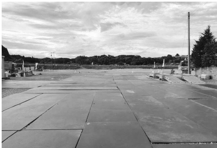
造成工事中の「仮称道の駅なみえ」
