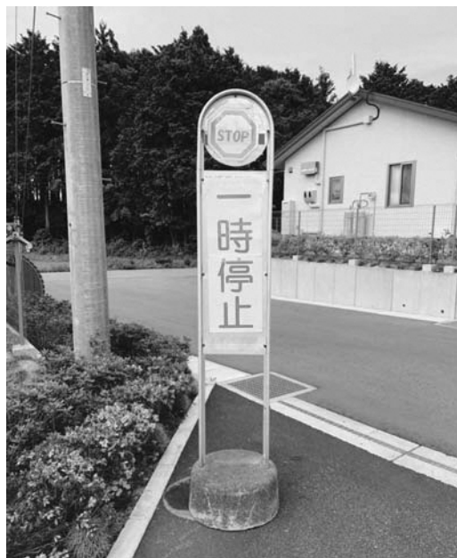
強風で転倒する標識
