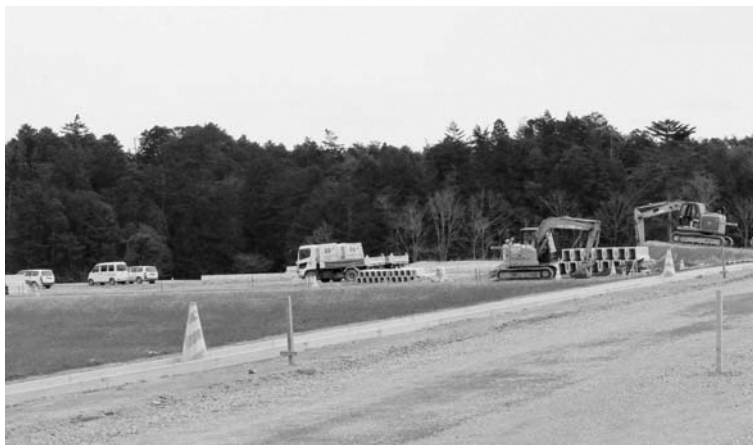
鹿島・泉田組JVが落札した工事現場
