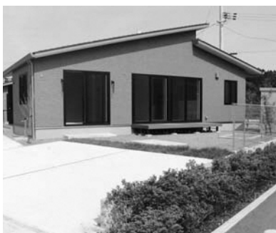
大平山に完成した請戸住宅団地
