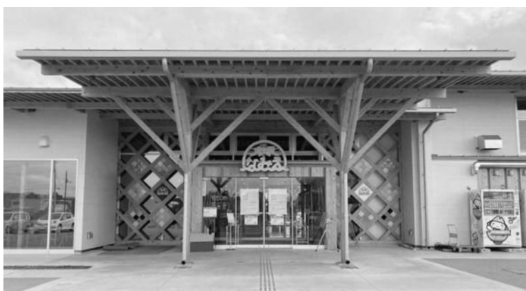
モニタリングポスト設置予定の道の駅
