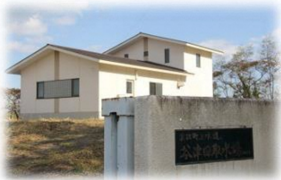
谷津田取水場
