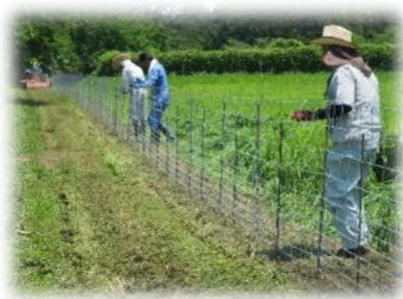
ワイヤーメッシュ柵の設置
