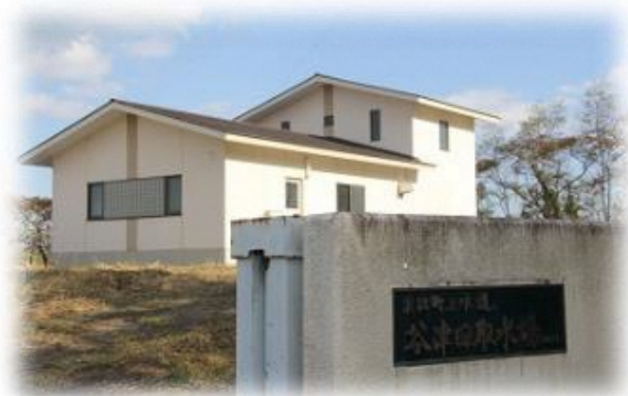
谷津田取水場
