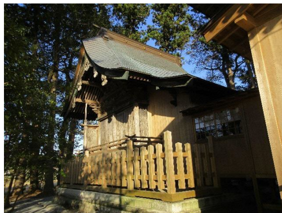
初発神社本殿（福島県指定重要文化財・建造物）
