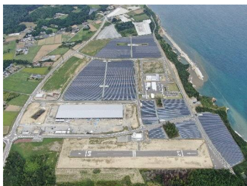
棚塩産業団地 福島イノベーション・コースト構想の3拠点が立地 ・福島水素エネルギー研究フィールド(FH2R) ・福島ロボットテストフィールド浪江滑走路 （福島RTF 浪江滑走路） ・福島高度集成材製造センター（FLAM）
