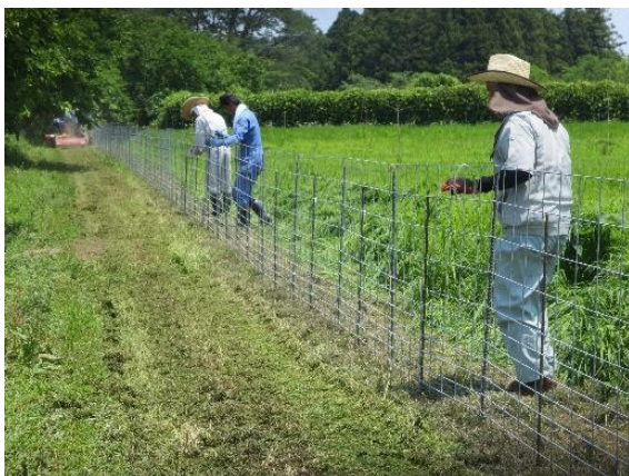
ワイヤーメッシュ柵の設置
