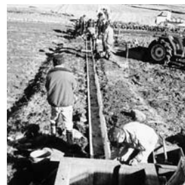
▲U字溝の埋設(小丸①)
