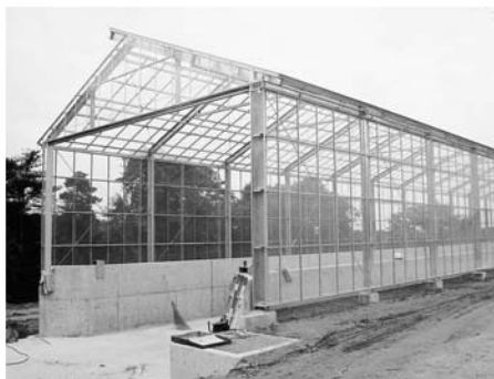
▲立野地区堆肥舎完成前 (立野字根岸)
