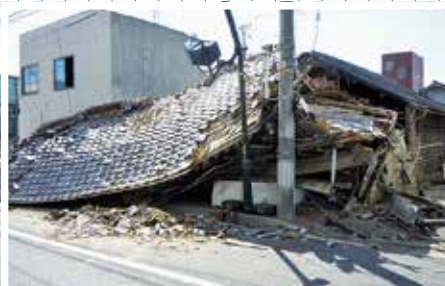
【権現堂地区】（2011〔平成23〕年3月12日撮影） 家屋の倒壊により街灯が傾き、道路へ屋根が崩れ落ちている。
