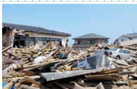
【両竹地区】(2011[平成23]年4月16日撮影) 津波によって家屋や車等が流され瓦礫となって山積みしている。
