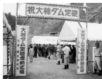
昭和55年7月29日大柿ダム定礎式
