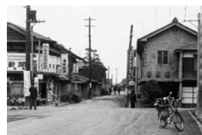
昭和36年浪江町通り道路拡幅工事
