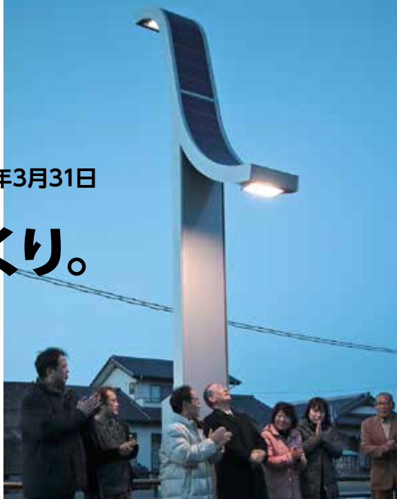
新しく設置された街路灯「THE REBORN LIGHT」
