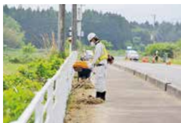
酒田地区に続いて、2015年5月末には立野下・高瀬地区の除染が終了。写真は同年7月の北幾世橋地区周辺での除染作業の様子（浪江町除染等工事その3）。幾世橋小のグラウンドも除染しました。
