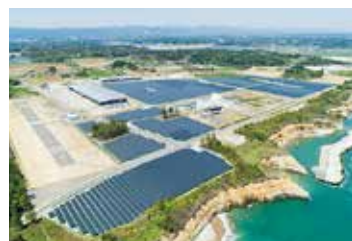
浪江町棚塩産業団地には、福島水素エネルギー研究フィールド（FH2R）、福島ロボットテストフィールド、福島高度集成材製造センター（FLAM）が立地し、町の復興、雇用促進に向けて期待が寄せられています。
