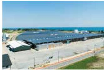
棚塩産業団地に整備中の「福島高度集成材製造センター」。集成材製品の製造と、製品化に必要なラミナ（挽き板）の生産を一貫して行います。将来はCLT（直交集成板）の製造も視野に置いています。
