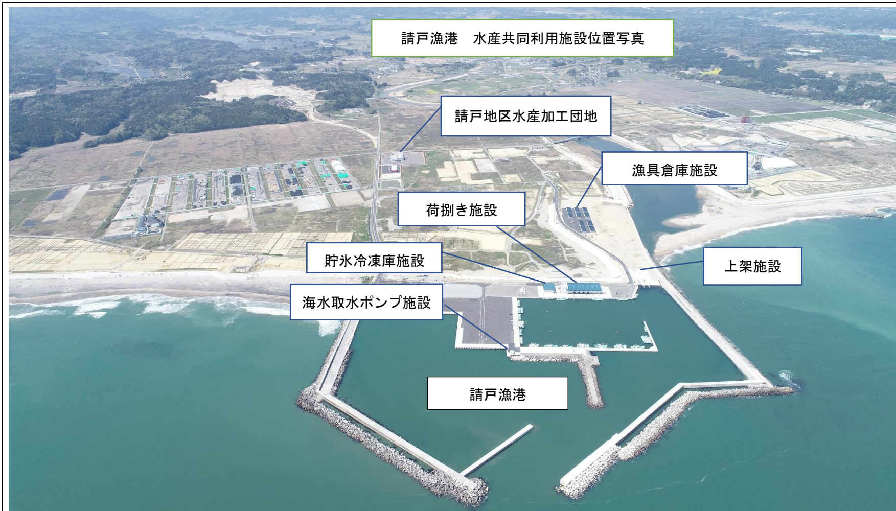
請戸漁港 荷捌き施設、貯氷冷凍庫施設、海水取水ポンプ施設、上架施設、漁具倉庫施設 位置写真
