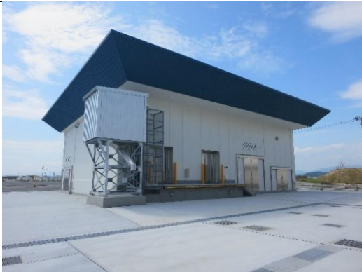
今回整備された貯氷冷凍庫施設
