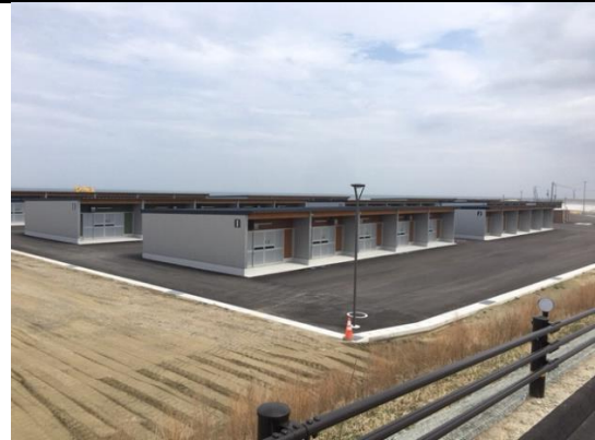
今回整備された漁具倉庫施設
