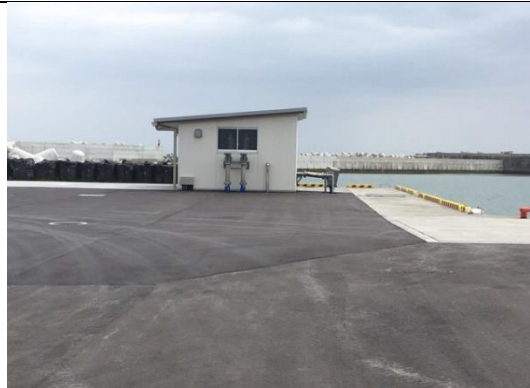
今回整備された海水取水ポンプ施設
