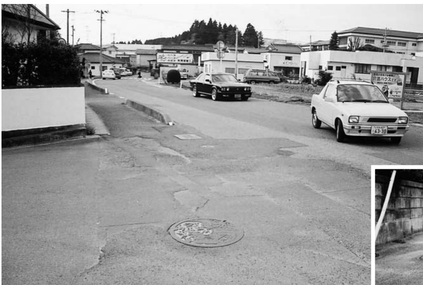
工事後の整備がまたれる町道
