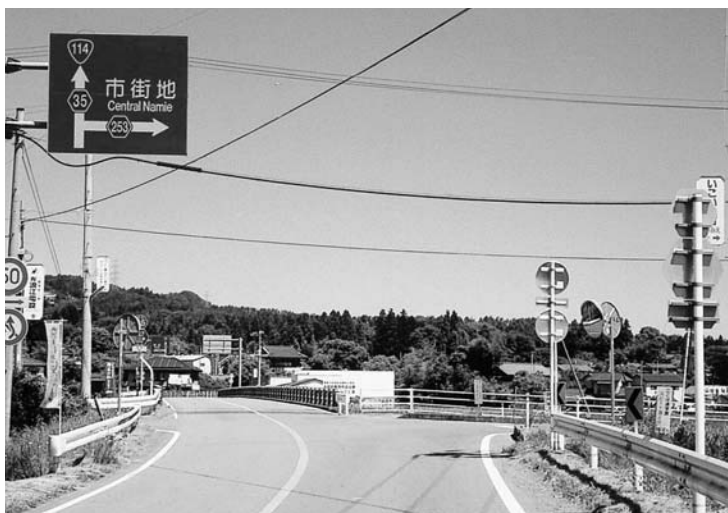
信号機未設置交差点（浪江線井手北川原地内）
