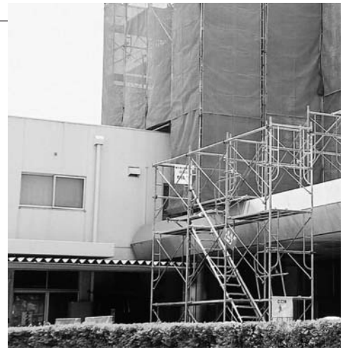
改修工事が進む浪江小
