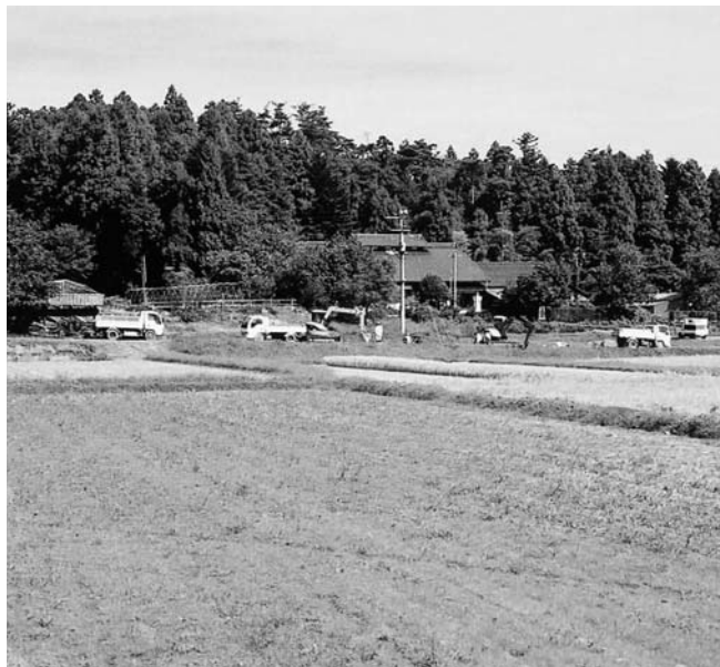
末森地区上水道整備が進む
