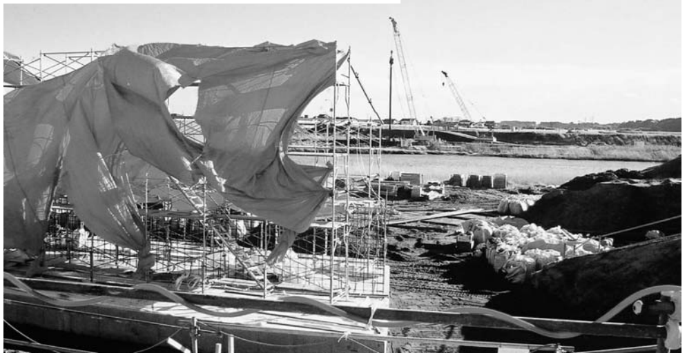
工事が進む 県道広野・小高線 (浜街道)
