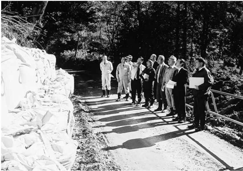
土砂くずれ災害現場の調査
