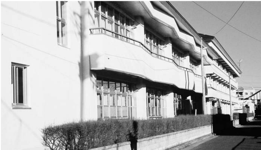
改修工事が終了した浪江小
