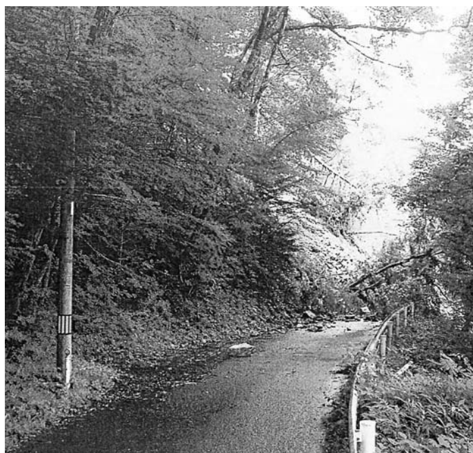
寸断された生活道路
