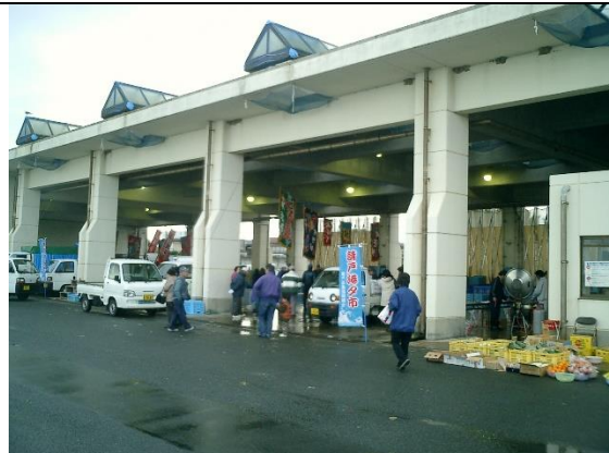
震災前 荷捌き施設
