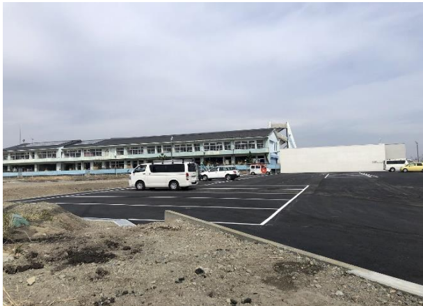
整備後写真↓ 管理棟新設
