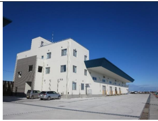
今回整備された荷捌き施設
