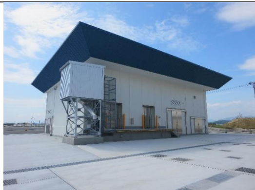
今回整備された貯氷冷凍庫施設
