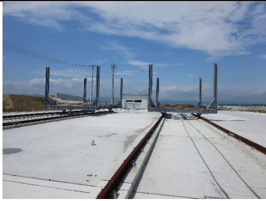
今回整備された上架施設
