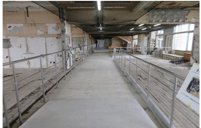
手摺り・落下防止ネット・防鳥ネット設置ほか
