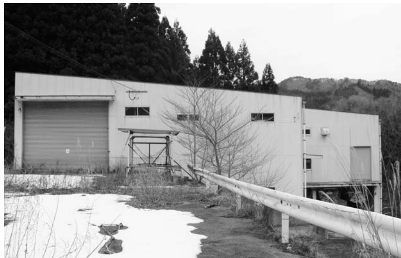
解体が待たれる旧焼却場
