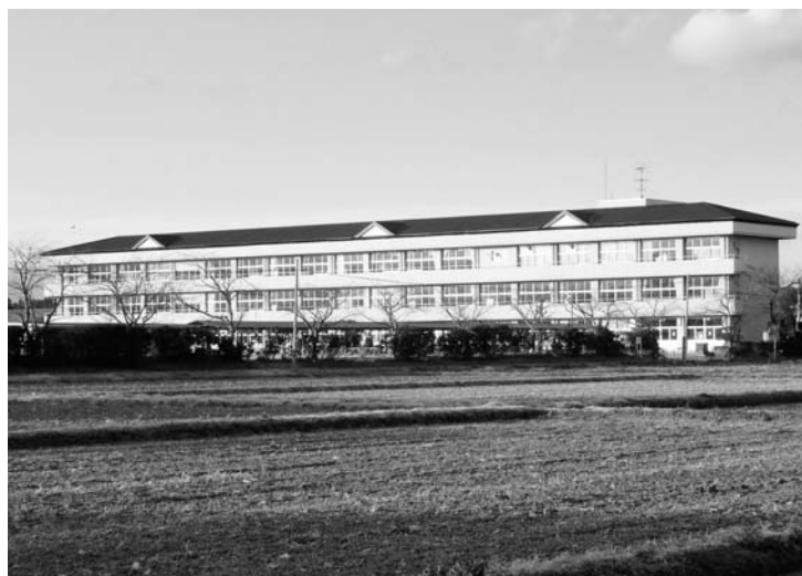
18年度に耐震改修される浪江東中学校
