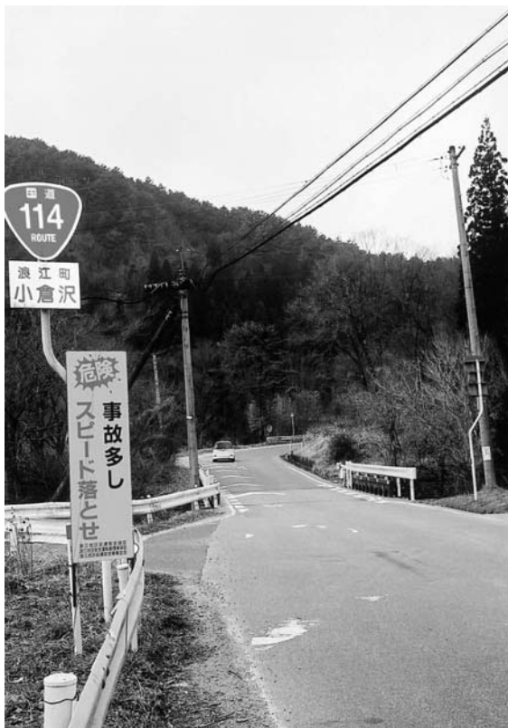
改良施工が決まった小倉沢橋 (津島地区)
