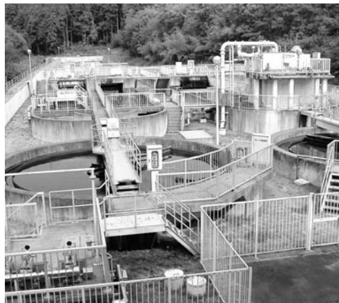
増設による負担増が見込まれている終末処理場
