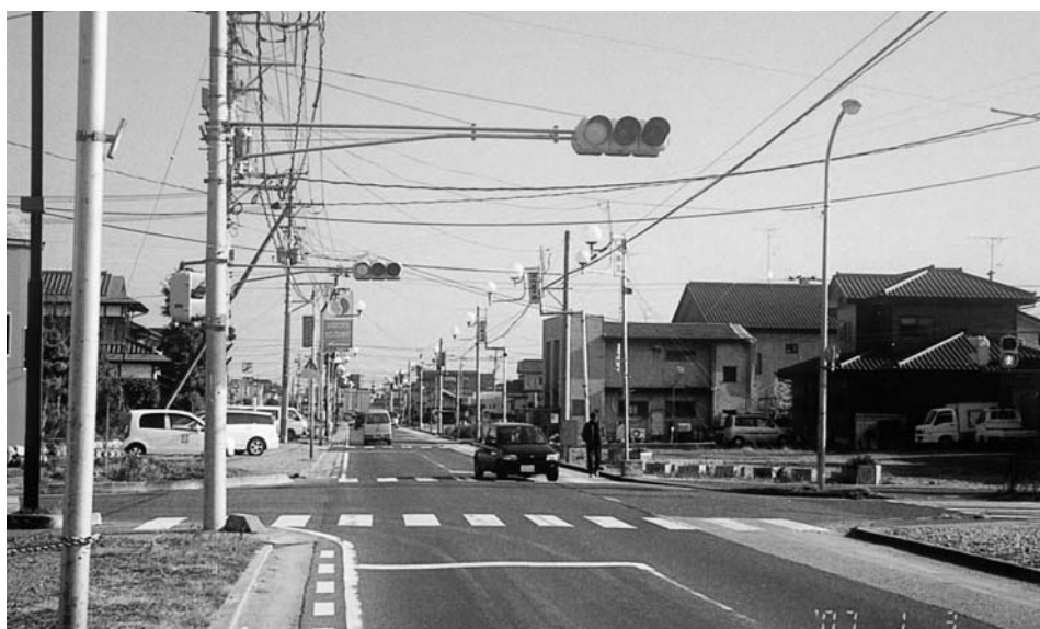
早急な整備が待たれる国道114号拡幅
