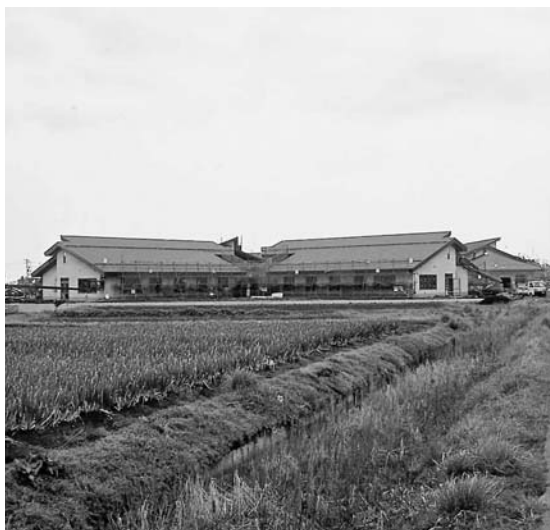
建設が進む老健施設
