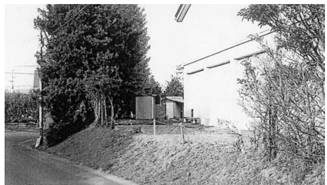
不審者侵入防止柵の設置を（浪江中学校）
