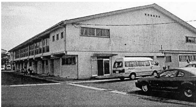
老朽化の進む第2体育館
