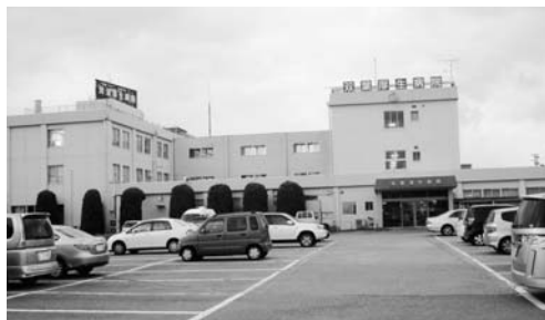
統廃合が検討されている双葉厚生病院
