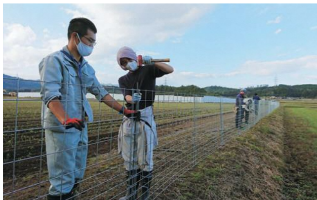
獣害対策のフェンスを設置
