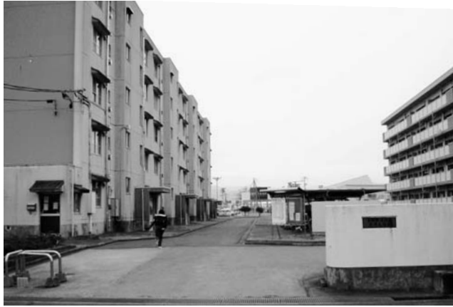
存続が心配される雇用促進住宅
