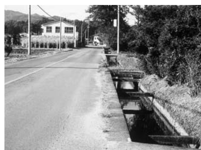
早急にガードレールの設置を（川添小丸田地内）
