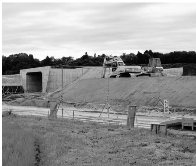
開通に向け急ピッチで進む高速道
