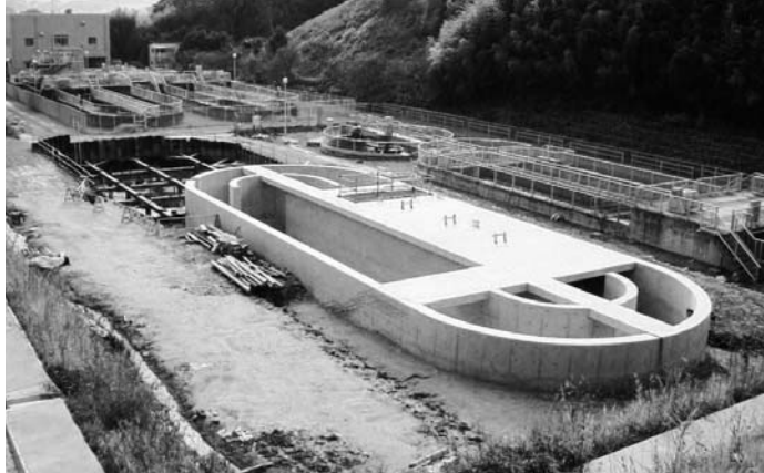
増設工事が進む下水道最終処理場 (北幾世橋地内)
