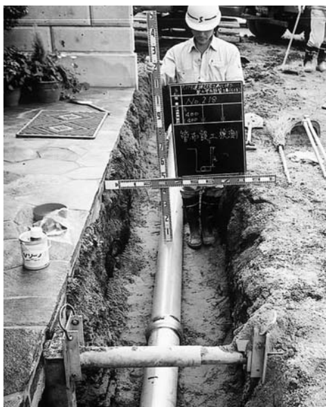
健全経営の基盤づくりを (水道仮設工事)
