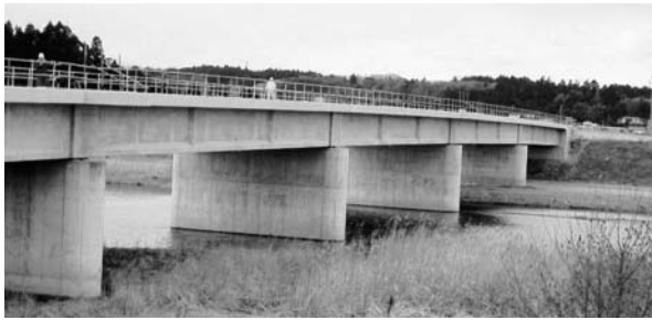
完成までもない請戸橋
